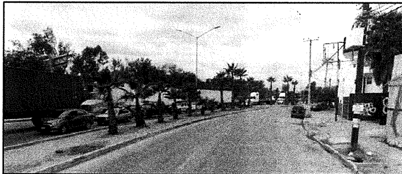
Imagen 2. Inicio del tramo de rehabilitación en el Blyd. Garita de Otay.
