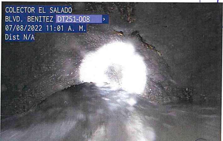
TUBERÍA DE CONCRETO CON DESGASTE
