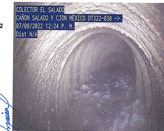
TUBERIA DE CONCRETO CON DESGASTE
