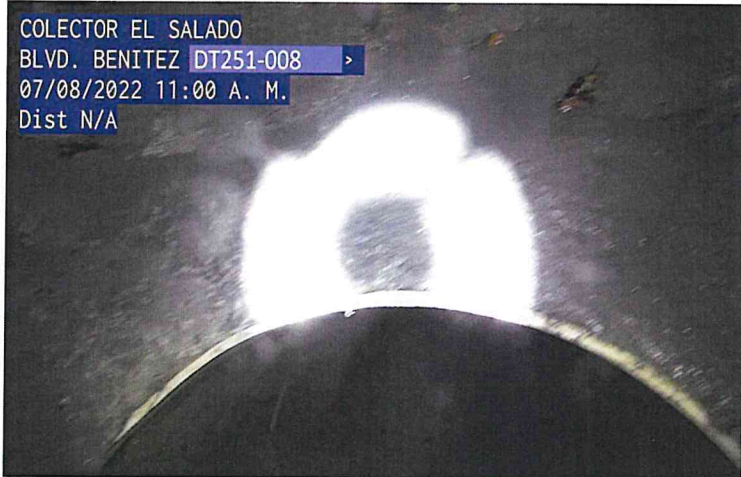
TUBERÍA DE PVC EN BUEN ESTADO
