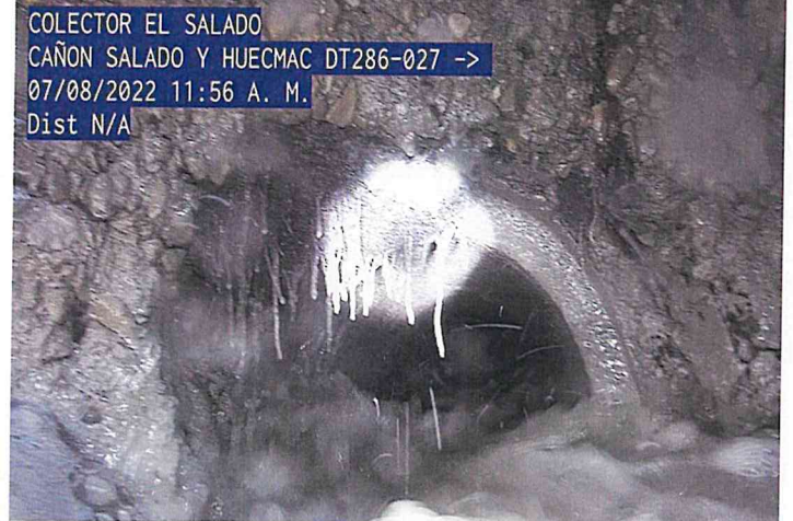
TUBERIA DE CONCRETO CON DESGASTE
