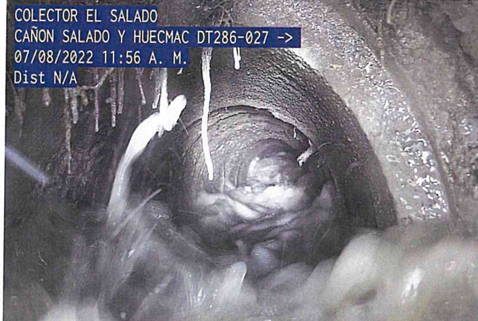
TUBERIA DE CONCRETO CON DESGASTE
