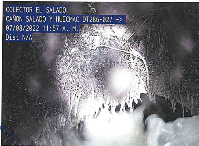
TUBERIA DE CONCRETO CON DESGASTE
