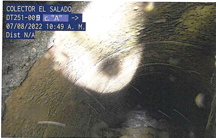
TUBERÍA DE PVC EN BUEN ESTADO
