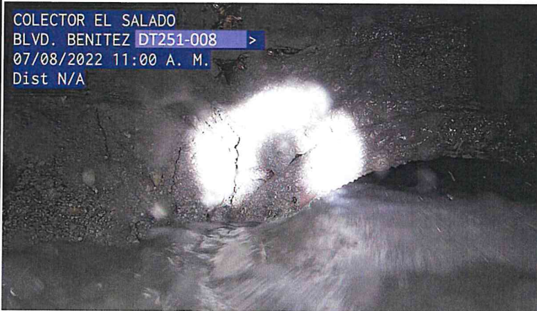
TUBERÍA DE CONCRETO CON DESGASTE
