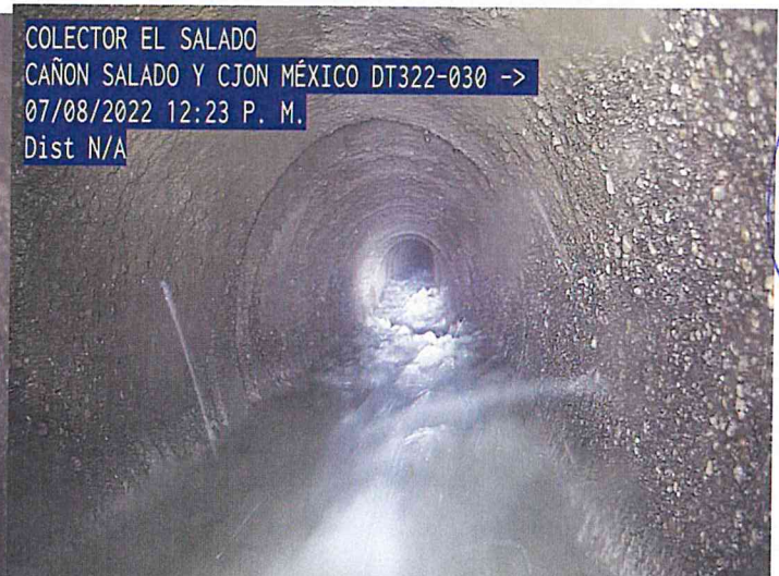
TUBERIA DE CONCRETO CON DESGASTE
